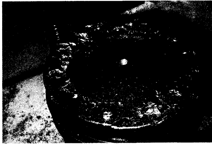
Een beschadigde zuigerkop door een losse klep.
